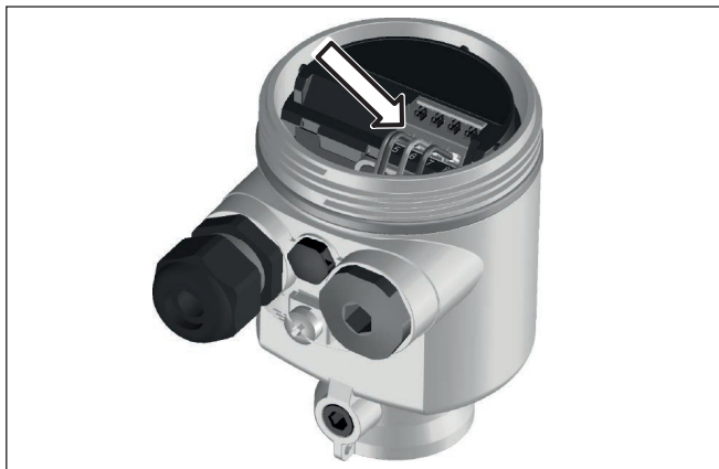
Fig. 15: Passos 5 e 6 do procedimento de conexão
