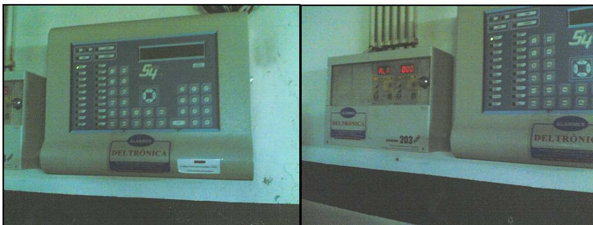
Figura 4.2 – CDI e Central de Detecção de Monóxido de Carbono (CDCO), no Estacionamento.
