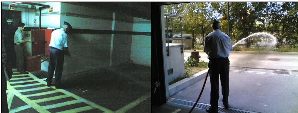
Figura 4.17 – Teste às Bocas-de-incêndio do Parque de Estacionamento
