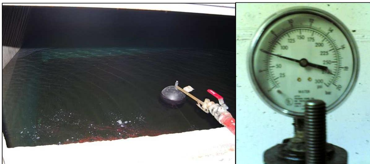
Figura 4.14 – Esquerda: Cisterna com Reserva de Água para Incêndio. Direita: Manómetro indicando a Pressão na Rede de Incêndio de 6 bar. Fotos: Mário Rui.
