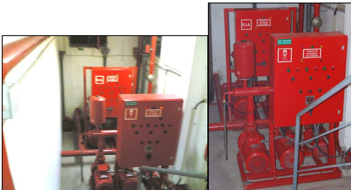
Figura 4.5 – Central de Bombagem e Grupos de Bombagem de Incêndio da RIA e Sprinklers, em detalhe. Foto: Mário Rui
