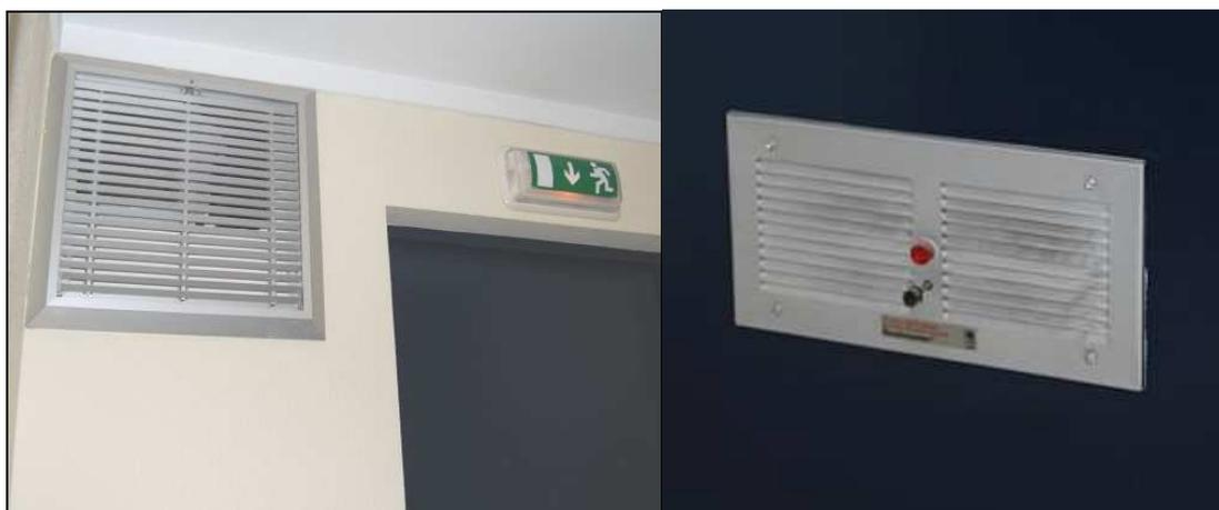
Figura 4.10 – Registo Corta-fogo e Grelha de Transferência numa Câmara Corta-fogo.
