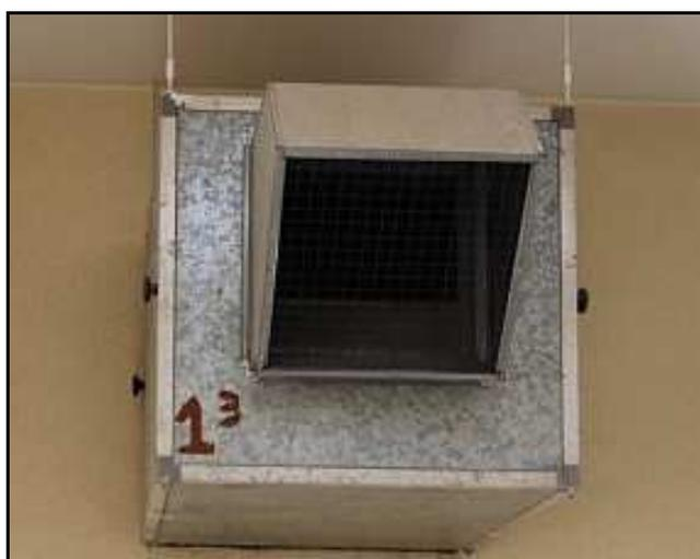
Figura 4.7 – Ventilador de Pressurização do Interior de uma das Caixas de Escada. Foto: Mário Rui.
