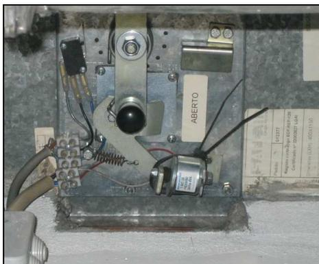
Figura 1.11 – Registo corta-fogo desactivado com abraçadeira de plástico
