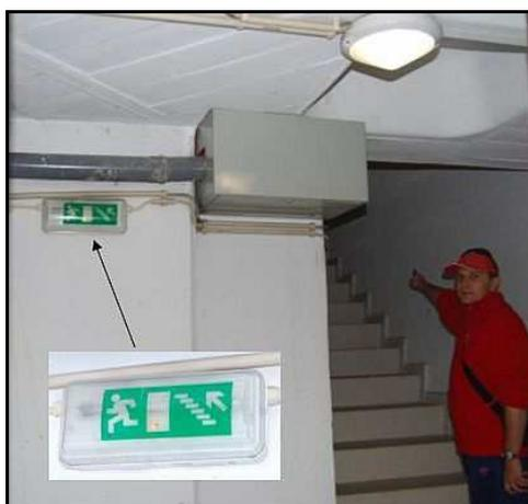
Figura 4.6 – Pictograma em Letreiro de Saída: com Indicação de Saída para o Lado Errado.
