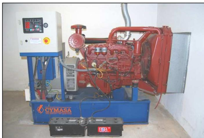
Figura 4.12 – Grupo Gerador de Emergência, depois de reparado. Foto: Mário Rui.
