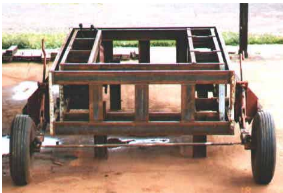
Figura 29. Vista geral do equipamento com as rodas de levantamento em fase de construção
