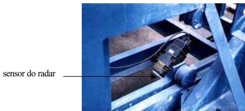
Figura 36. Instalação do radar na parte traseira do equipamento
