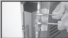
4. Coloque a arnela de vedação dentro da rosca interna da mangueira metálica.
