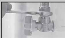
7. Após a instalação, verifique se há vazamento de gás, abrindo o registro de gás e colocando um pouco de espuma de sabão em todas as conexões que foram manuseadas. Se houver formação de bolhas, feche o registro regulador e refaça a operação ou consulte a **Rede de Serviços Brastemp**.
