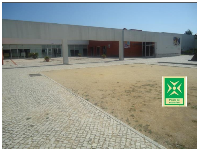
Figura 12: Ponto de encontro da biblioteca, junto à entrada principal.
