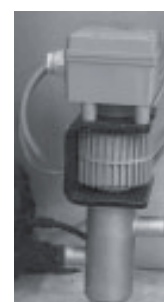
Válvulas de expansão electrónicas
