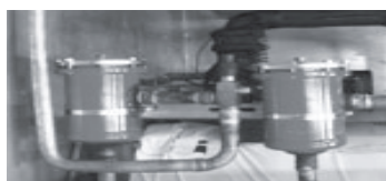
Filtro/secador de núcleo substituível
