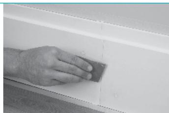
Antes de iniciar a pintura, remova totalmente o pó do lixamento. Evite manchar o piso durante a pintura, colocando fita adesiva sobre ele. Após a secagem das demãos de tinta, remova a fita.
