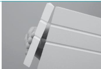
Vire a serra num ângulo de 45° e corte um pedaço da barra de rodapé de onde já foi retirado o acabamento de topo. Após o corte, a parte da frente do rodapé deve ser maior que sua base.
