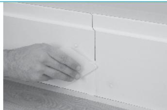
Espere secar completamente e lixe levemente a massa para eliminar asperezas.
