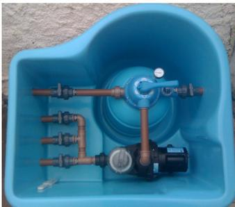
A Casa de Máquinas em Fibra de Vidro é ideal para quem quer praticidade e facilidade na hora de manusear os registros e o sistema filtrante da piscina (Filtro de areia e bomba). Sua instalação é bem rápida e prática. Já vai com tampa hermética, o que impede a entrada de água.
