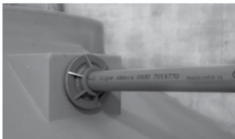
**PASSO 9** Em seguida, conecte os tubos nas flanges.
