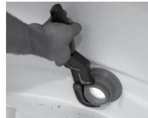
**PASSO 5** Aperte manualmente as flanges pelo lado interno da cisterna. Se necessário utilize uma chave de grifo para ajustá-las. Atenção! Faça isso com cuidado, de forma a garantir a junção perfeita das peças sem danificá-las. O uso de flanges com vedação de borracha dispensa vedação adicional, com silicone, por exemplo.
