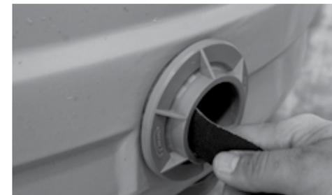
**PASSO 6** Depois, inicie a instalação da tubulação utilizando tubos de bitolas equivalentes as das flanges. Para facilitar a execução, lixe as flanges.
