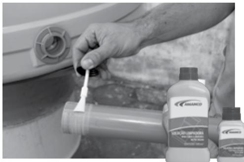
**PASSO 8** Passe o adesivo plástico para PVC nas flanges e nos tubos que serão conectados. Mas antes use solução limpadora para melhor aderência do adesivo para PVC.
