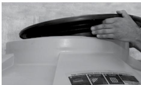
**PASSO 13** Após ser fechada com a tampa, a cisterna estará pronta para ser conectada à rede hidráulica e utilizada.
