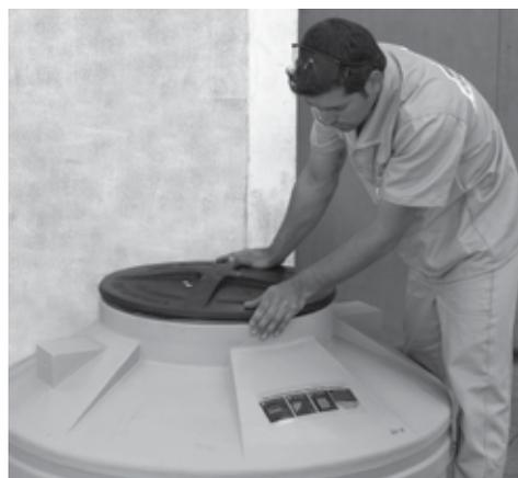
**PASSO 1** Retire a tampa para começar a instalação da cisterna. O assentamento deve ser feito somente sobre superfície plana e nivelada.
