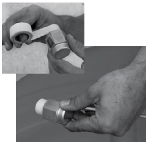
**PASSO 10** Do lado interno da cisterna, instale a torneira de bóia junto à flange de entrada de água. Para tanto, fixe a torneira separada da bóia. Não se esqueça de usar fita veda-rosca Amanco para instalar a torneira de bóia.
