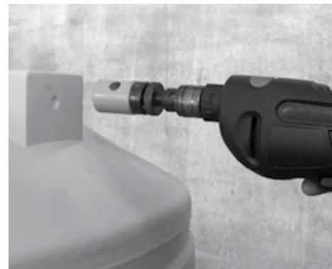
**PASSO 2** Inicie a furatura da cisterna nos pontos indicados pelo fabricante (ver pág. 9, fig. 7). Para isso, utilize serra-copo compatível com o diâmetro das flanges.
