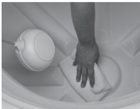
**PASSO 12** Antes de concluir, limpe toda a cisterna com um pano úmido, em especial o lado interno, para garantir a retirada de partículas e outros resíduos.
