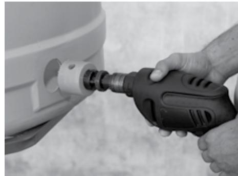
**PASSO 3** Certifique-se que a cisterna tenha no mínimo 3 furos, sendo: um para a entrada d'água, um para a saída d'água e um terceiro para o extravasor (ladrão).
