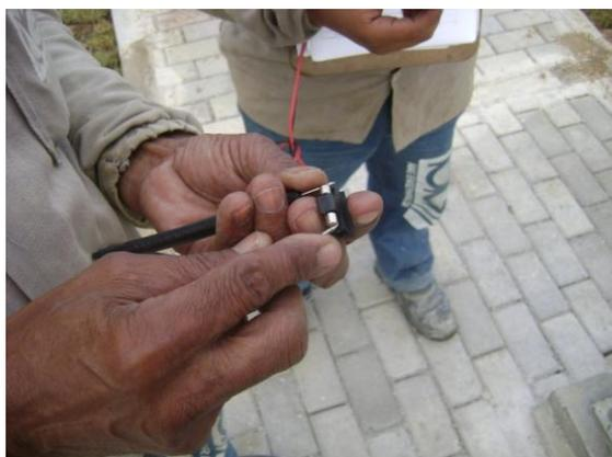
Figura 20: Verificação dos fusíveis de proteção inseridos nos bornes
