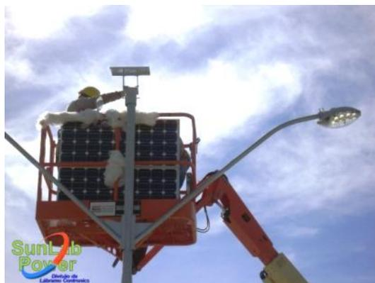
Figura 9: A instalação do suporte sem os painéis.
