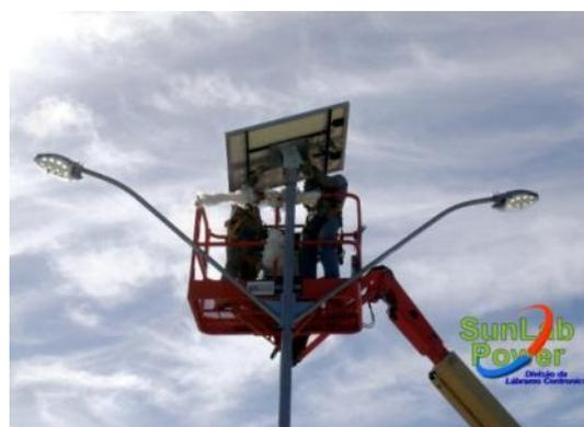
Figura 11: Instalação dos painéis no suporte.
