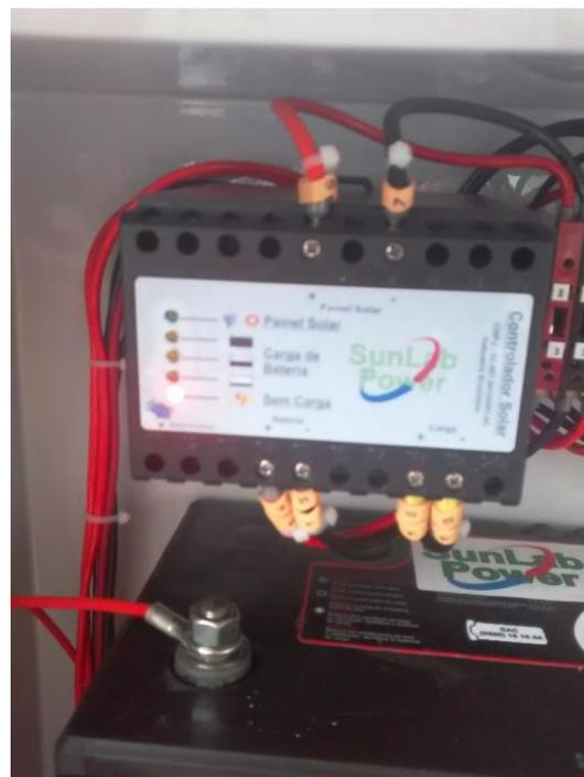
Figura 23: Controlador em funcionamento
