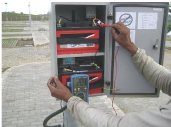
Figura 19: Verificação da ligação e tensão gerada pelas baterias.
