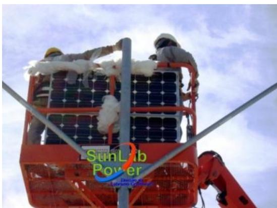
Figura 8: Instalação da base regulável. O suporte pode ser içado com os painéis já fixados.
