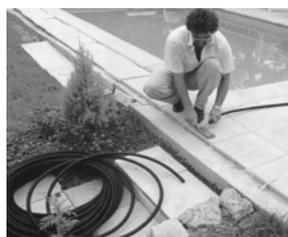
Ter em atenção de que o comprimento com que se deve cortar o tubo deve ser 10 cm menos do que o comprimento final do colector, devido a que cada tubo de distribuição tem 5 cm.
