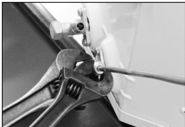
Figura 31 - Flixação da porca
