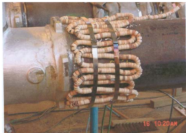
Detalhe do posicionamento das resistências.
