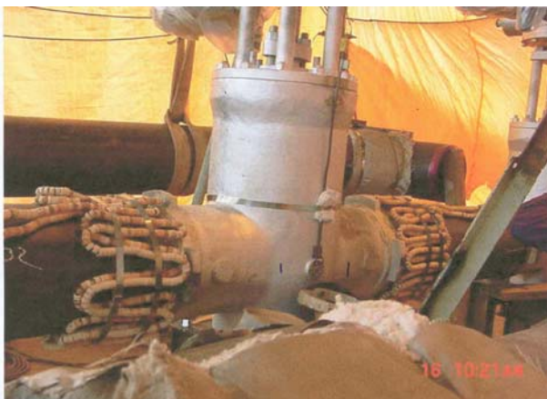
Corpo da válvula com resistências posicionadas de forma correta somente nas regiões dos biséis.
