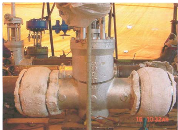
Corpo da válvula com as resistências montadas e isoladas termicamente prontas para início de tratamento térmico nas juntas soldadas.
