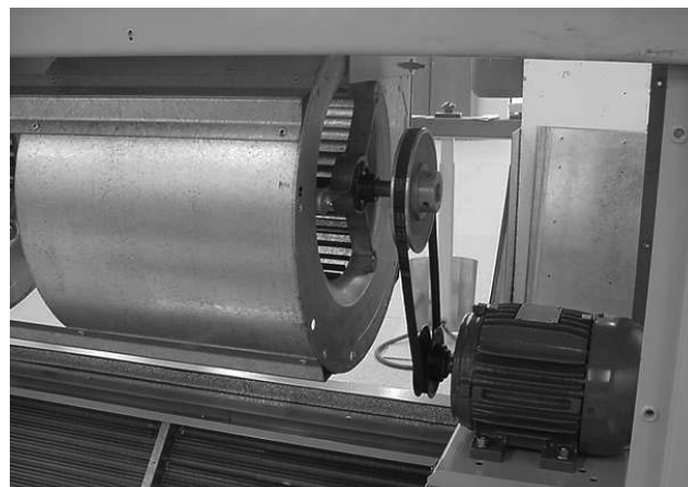
Figura 16 - Motor do Ventilador
