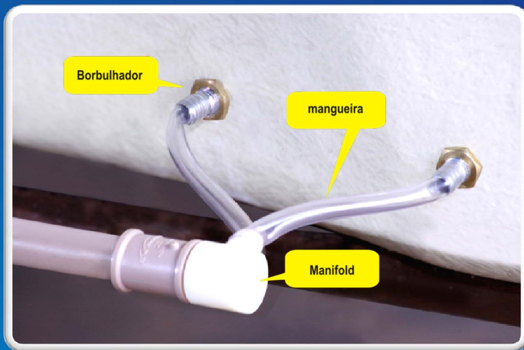
A conexão com os Borbulhadores pode ser feita com o uso de mangueira comum e manifolds.
