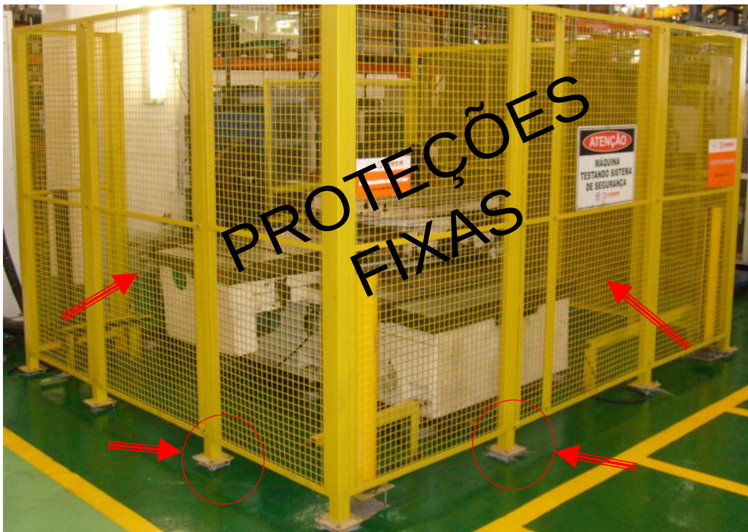
PERIMETRAL - SOLDADA E CHUMBADA NO PISO
