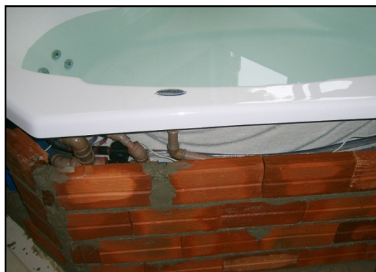
Figura 15: Acabamento Lateral em Alvenária
