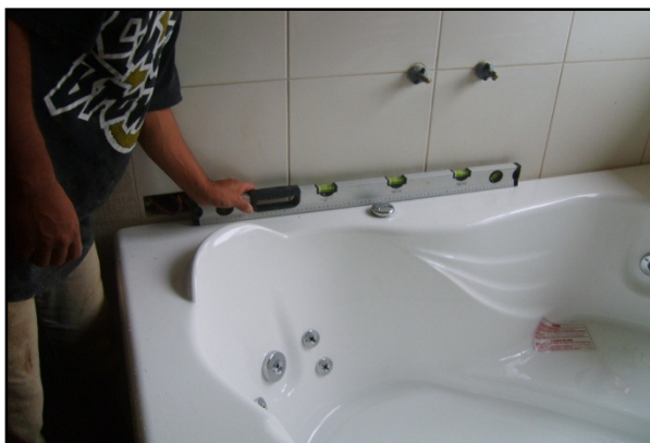
Figura 13: Nivelamento
