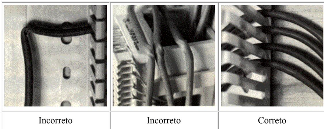
Devem ser deixadas sobras de cabos após a montagem das tomadas, para futuras intervenções de manutenção ou reposicionamento. Essas sobras devem estar dentro do cálculo de distância máxima do meio físico instalado:
