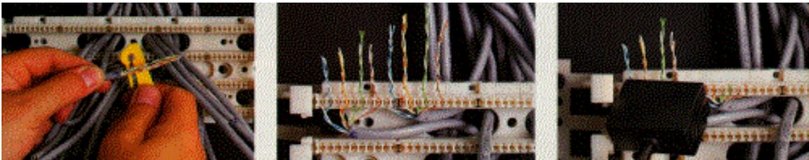
*Seqüência de instalação de cabos UTP. Observar o comprimento de pares destrançados limitado ao máximo de 13 mm.*
