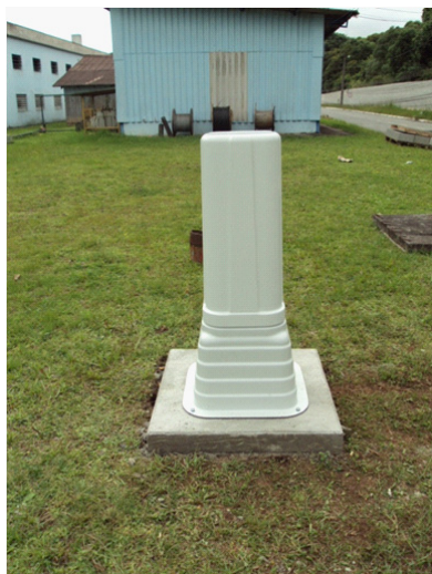
Figura 2 - Exemplo de pedestal instalado em base de concreto.
