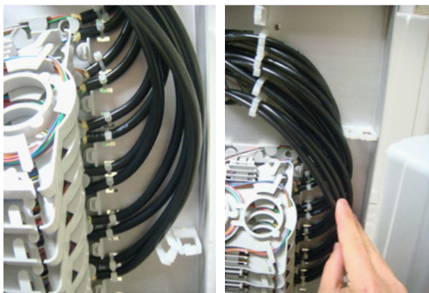
Figura 9 - Detalhe da fixação dos service cables
