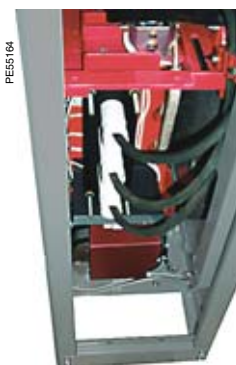
Entrada dos cabos na estrutura
