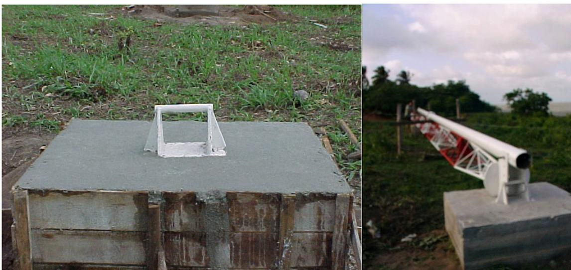
Figura 5.10 - Acoplamento articulado fixo à base central para encaixe da torre.
