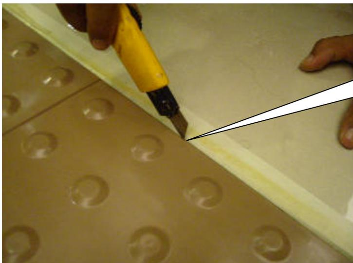
O uso de estilete auxilia no corte da camada de cola aplicada no piso e permite um arremate perfeito
