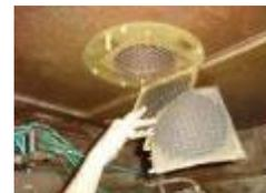
Após o buraco central ser aberto, marque quatro furos para os parafusos M8 e as porcas que irão fixar este flange a carenagem da máquina, entre a máquina e o flange, colocar silicone nitrílico para fazer a vedação. Aperte os parafusos com as porcas e esta etapa esta pronta.
