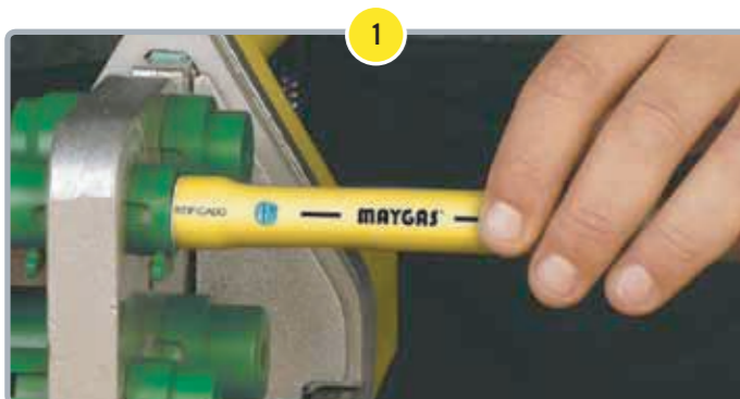
Passo 1. O tubo é inserido até tocar o fundo do bocal.
