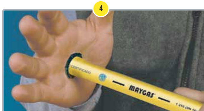
Passo 3. Transcorrido o tempo adequado a cada diâmetro (ver Tabela de Tempo de Solda para o tempo de aquecimento e resfriamento), ambos elementos são retirados dos bocais e devem ser unidos.
