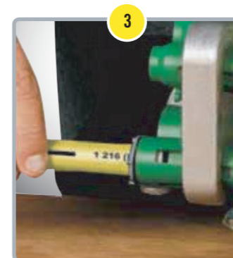
Passo 1. Com o aparelho ligado (luz verde acesa), a conexão e o tubo são introduzidos nos respectivos bocais do termofusor.
