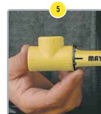
Passo 5. Deixa-se transcorrer o tempo mínimo de aquecimento indicado na Tabela de Tempo de Solda. Retiram-se o tubo e a conexão dos seus respectivos bocais. Une-se o tubo e a conexão. Por fim, pressiona-se o tubo contra a conexão de forma que fique totalmente introduzido.
