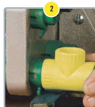
Passo 1. Com o aparelho ligado (luz verde acesa), a conexão e o tubo são introduzidos nos respectivos bocais do termofusor.
