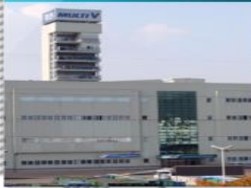
Teste Desnível e comprimentos de tubulação
