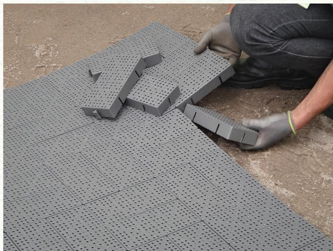
2.5- Depois de montado, utilize um socador ou uma placa vibro compactadora para que o Paver adentre na camada de assentamento, chegando até a base, de forma que seu interior fique totalmente preenchido.
