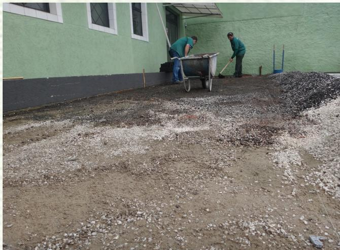
2.2- Prepare o solo, nivelando a terra. Para passagens de veículos, o solo existente deverá apresentar resistência para esse tipo de aplicação, se necessário, reforce o solo com pedra;
