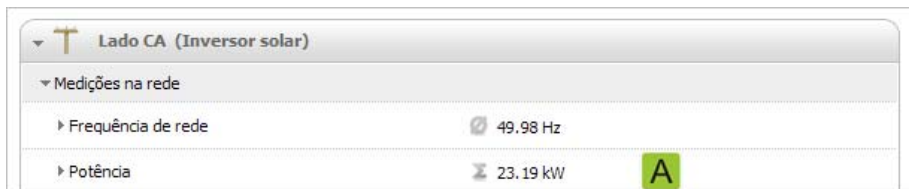
Figura 2: Soma da potência dos inversores ao seleccionar a vista de sistema (exemplo)
