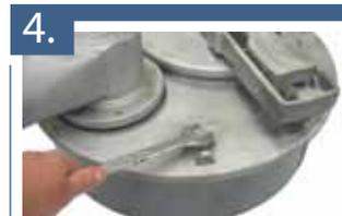
4. Após realizar teste hidrostático, rosqueie o bujão tupy 3/4" BSP na tampa de visita. A existência do anel de vedação dispensa o uso de teflon na vedação do bujão.
