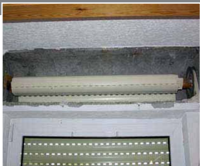
1 Vista após a abertura da caixa de estore.
