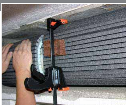
7 Tire as medidas para placas de isolamento adicionais se necessário.
