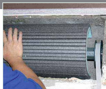
6 Instalação da placa de isolamento. As extremidades da placa precisam ser fixas através de um colchete ou outro travão apropriado.
