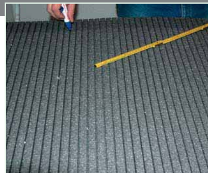
3 Transferência das medidas para a placa de isolamento. Opcional: corte para a fita ou cabo do motor.
