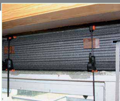
8 Fixação da placa de isolamento com um suporte.
