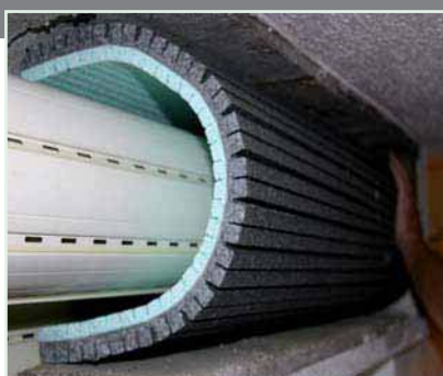
5 Confirmação do comprimento e espaço restante para o estore de enrolar. Se possível: Instalação do isolamento na parte lateral.
