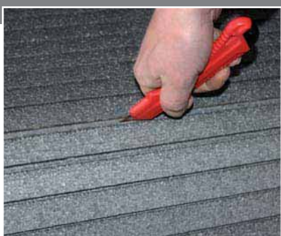
4 Adaptação às dimensões estabelecidas cortando com uma ferramenta de corte própria (exemplo: um x-acto).
