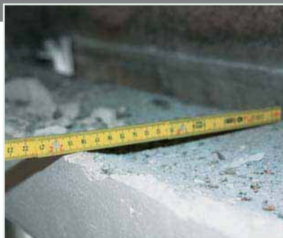
2 Medição da cavidade. Determinação do comprimento, largura e espessura da placa de isolamento.
