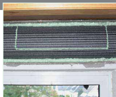
12 Para acesso posterior ao estore, corte uma abertura rectangular dentro do isolamento e feche-a novamente com espuma de poliuretano.
