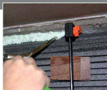
9 Isolamento e fixação em torno da placa com espuma de poliuretano.
