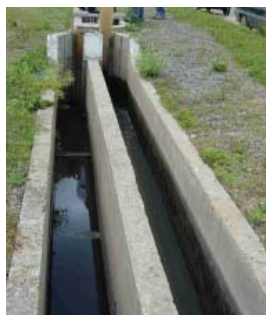
Desarenador de limpeza manual
