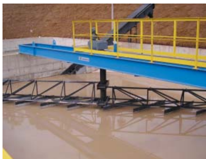
Desarenador de limpeza mecanizada
