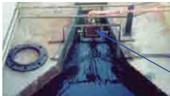
Misturador hidráulico – medidor Parshall
