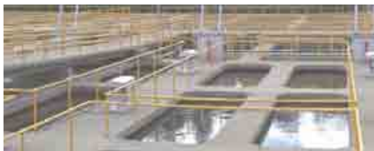
Floculador mecanizado
