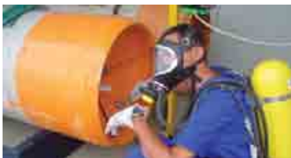
Troca de Cilindro de cloro
