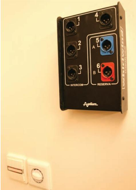
Uma das muitas caixas de ligação espalhadas pelo edifício e fornecidas pela Audium para as comunicações técnicas na rede infra-estruturada por cabo. Por baixo, vemos os interruptores de iluminação controlados por E.I.B. e ainda reguladores de volume que equipam várias salas do edifício
