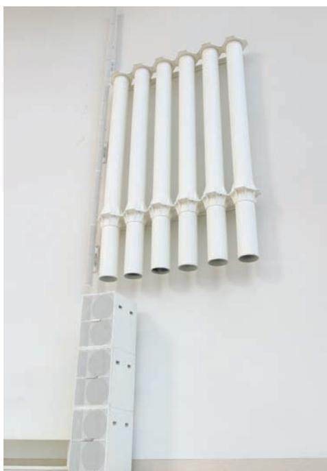
O conjunto Bose desenhado especificamente para a difusão do coro e órgão conta com as Wave Cansons Bose de modo a permitir a extensão sub-grave das baixas frequências do órgão, 4 graves MB24 e um conjunto de 6 MA12, tudo material fornecido pela António Barbosa & Castro e instalado pela Sislnt
