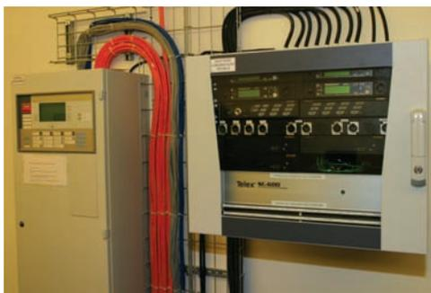
Na sala de gestão centralizada encontram-se a central de incêndio da Siemens à (esq.ª) e o bastidor das comunicações técnicas Telex SC-600
