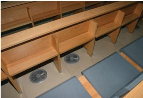
As condutas de ar condicionado no piso técnico (subterrâneo) desembocam em grelhas no pavimento da assembleia e do altar
