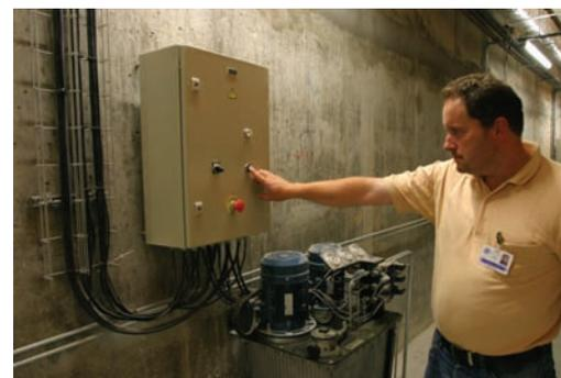
**A divisória móvel é uma das coqueluches da Igreja da Santíssima Trindade. A parede divide a assembleia elevando-se (com força hidráulica) até 2m. Vemos aqui José Ferreira, técnico de som do Santuário, a demonstrar o rigoroso procedimento de segurança que antecipa a operação**
