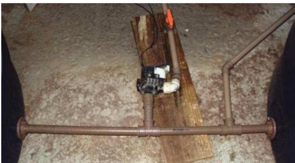
Figura 31 - Detalhes da bomba de circulação de água da fonte fria.
