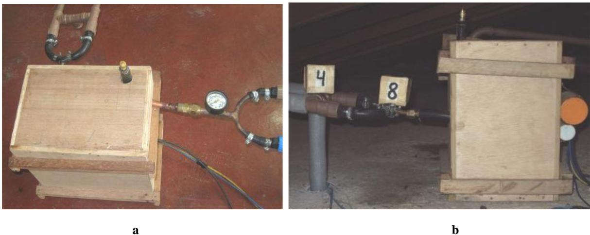
**Figura 19 (a) Compressor isolado com madeira antes da instalação; (b) conjunto instalado.**
