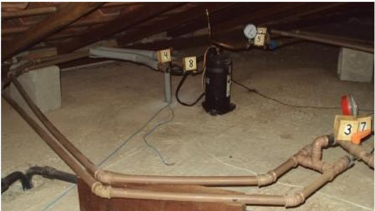
**Figura 24 - Detalhes da instalação do condensador**
