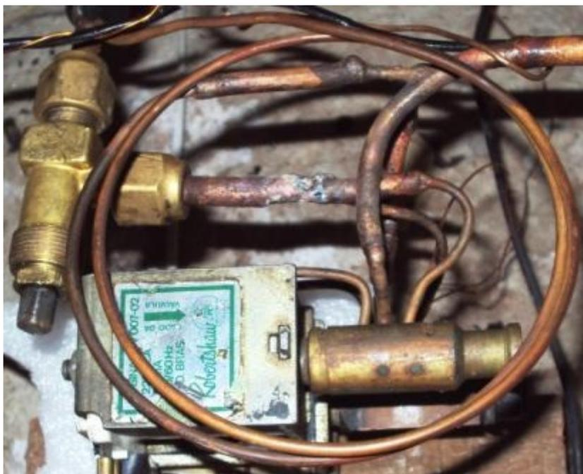
Figura 29 - Detalhes dos dispositivos de expansão utilizados no protótipo.
