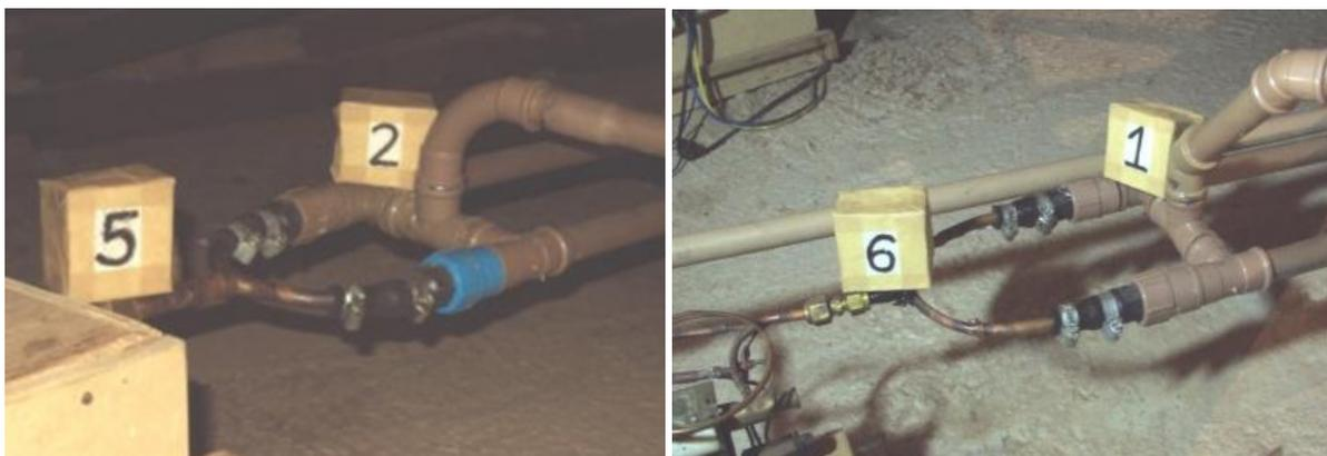
**Figura 26 - Detalhes dos pontos de entrada e saída de água e do refrigerante no evaporador.**
