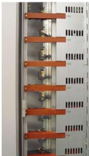
Vista posterior do CCM, barramento vertical no duto metálico e garras de saída
