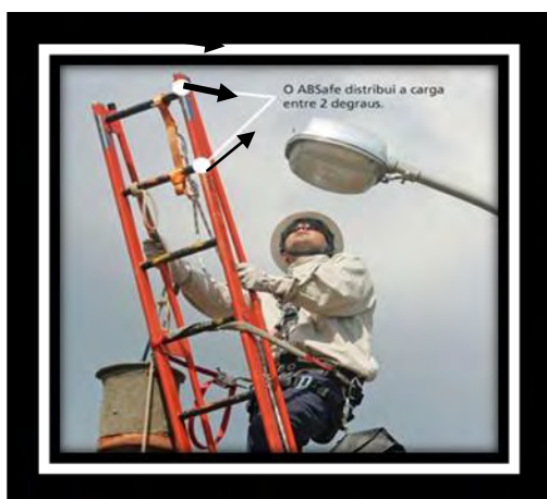
O TALABARTE DISTRIBUI A CARGA ENTRE DOIS DEGRAUS
