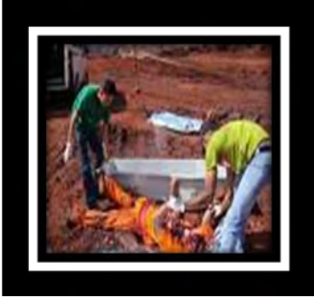
acidente fatal - O trabalhador foi esmagado pelo trator na obra.
