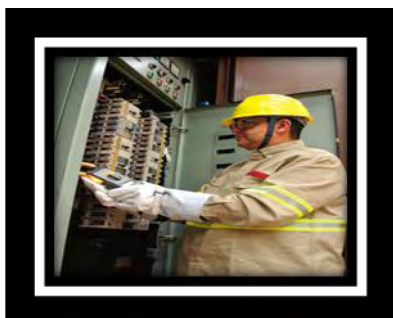
Funcionário devidamente vestido para trabalhos com eletricidade
