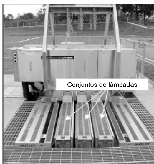
Figura 13. Processo UV com lâmpadas imersas e escoamento em canal.
