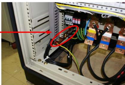
Figura 37 – Barra de aterramento.
