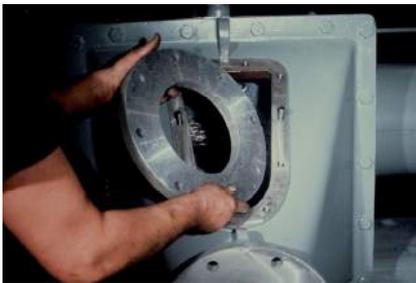
tratamento é reduzir a restrição na descarga. Primeiro passe o contrapeso da alavanca reduzindo o momento e se isso não for suficiente para reduzir a carga do motor, então remova o anel espaçador localizado na descarga da válvula flap. Normalmente a combinação de anel espaçador e posição de contrapeso são encontradas para que a bomba atinja a capacidade desejada com o mínimo consumo de energia.
