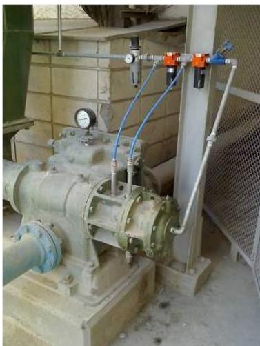
Deve-se fornecer ar de purga para a selagem às duas extremidades da bomba. A pressão de selagem dos mancais varia conforme a pressão da linha de transporte. Ver tabela da figura 4.
