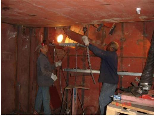
**Figura 60. Montador e aprendiz a colocar reforço na sua respectiva posição**
