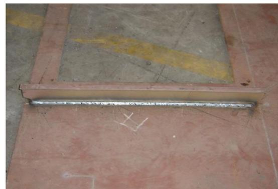
**Figura 102. Perfil soldado a antepara por meio de soldadura contínua**
