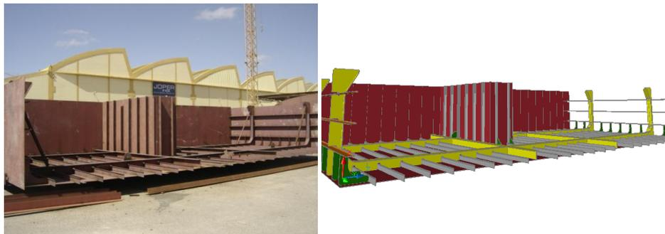
Figura 142. Bloco AC3 Vs. Modelo 3D AC3
