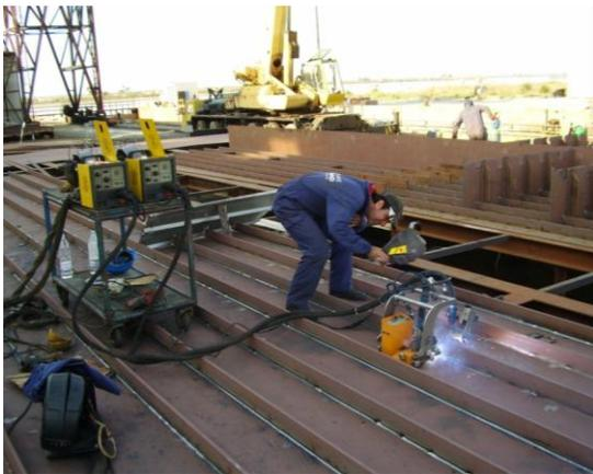
**Figura 62. Soldador a controlar soldadura dupla por robôs**
