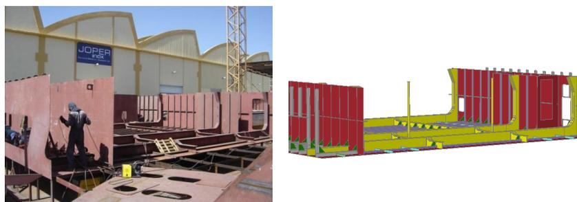
Figura 156. Bloco AC14 Vs. Modelo 3D AC14
