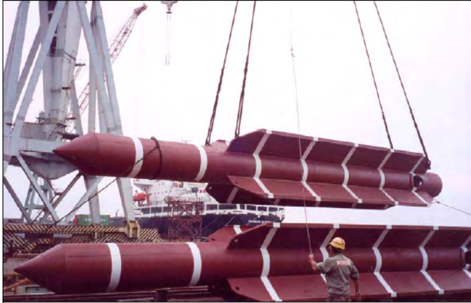
Figura II.2.4-61 - Estaca torpedo utilizada para ponto fixo de ancoragem.
