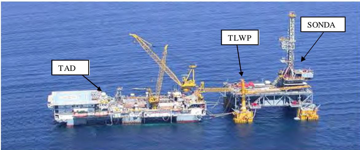
Figura II.2.4-10 - Ilustração de uma TAD operando em conjunto com uma TLWP.
