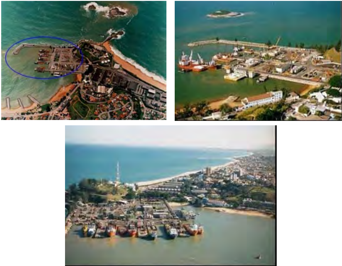
Figura II.2.4-67 - Terminal Marítimo de Imbetiba.
