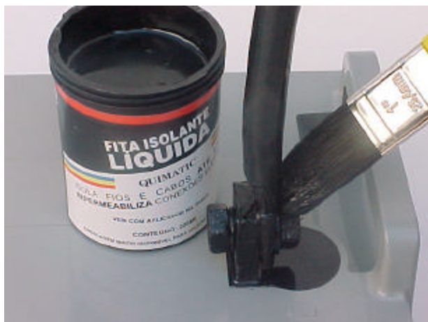
3 a – APLICAÇÃO DE FITA ISOLANTE LIQUIDA
