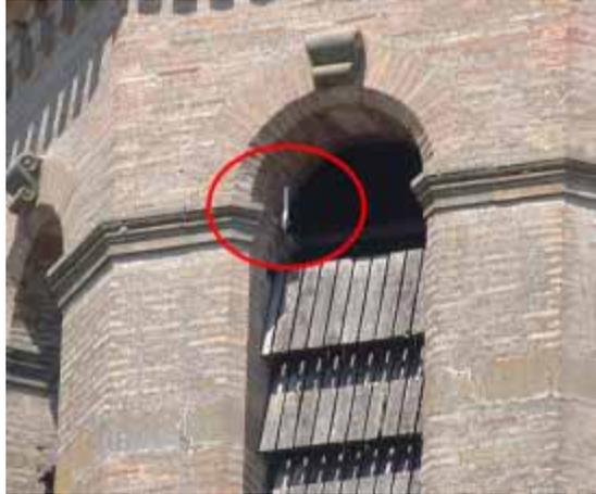
**Figura 43:** Antena omnidireccional do repetidor situado na *Eglise*
