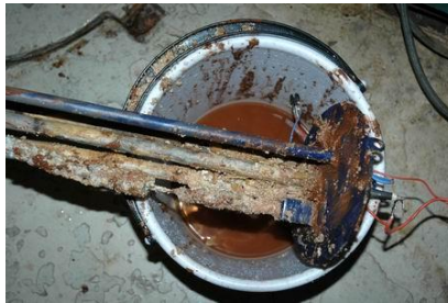
Acionamento de válvula visando remoção de material contaminante
