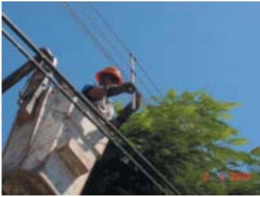
FIGURA 5. Instalação de Espaçadores
