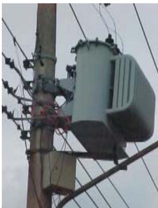
FIGURA 2 – Equipamento de medição junto ao transformador
