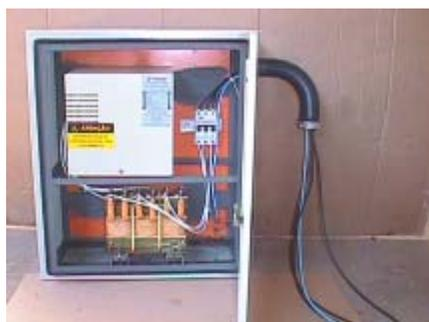
FIGURA 3 – (a): Diagrama trifilar simplificado; (b) aspecto final do filtro passivo sintonizado de baixa tensão.
