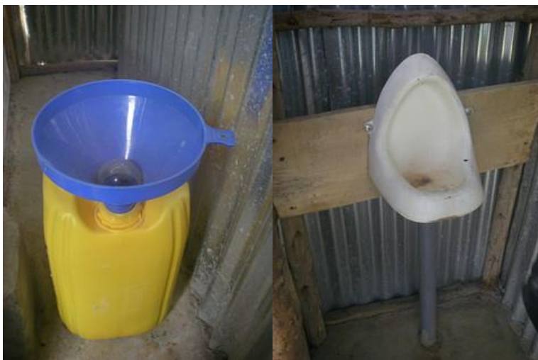
Figura A.10: Exemplos de urinóis de baixo custo. O modelo apresentado à esquerda é designado por 'eco-lily'. (Fonte: SuSanA).
