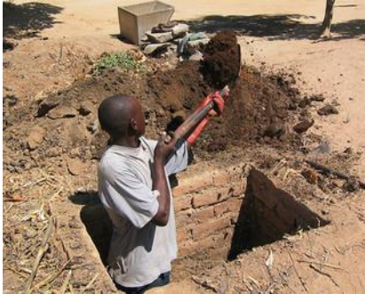
Figura A.23: Remoção manual do conteúdo de uma fossa alterna utilizando uma pá. Fonte: Peter Morgan.
