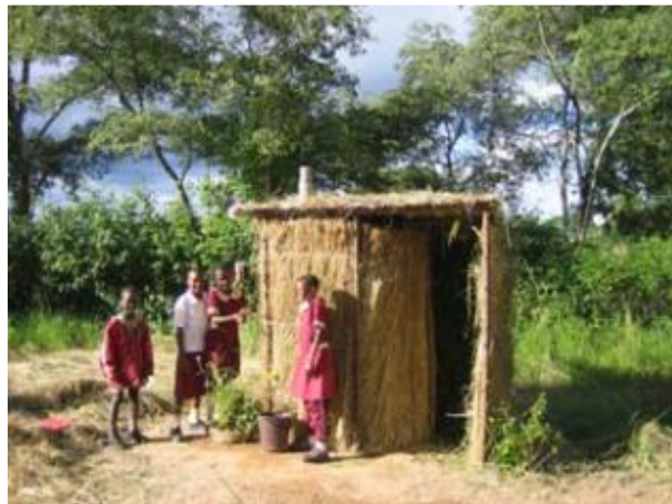
Figura 4.9: Aspeto de uma I.S. em espiral construída com recurso a palha. Fonte: Morgan, 2011.
