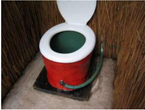
Figura A.7: Aspeto de uma sanita com separação de urina de baixo custo. Pode ser visto na parte frontal o tubo de saída da urina. Fonte (Morgan, 2007).
