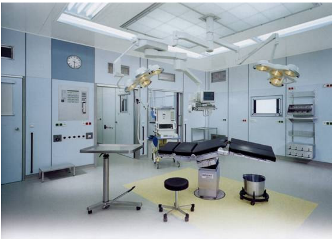
Figura 11- Sala de operações vendo-se em primeiro plano a mesa de cirurgia com tampo em pedestal. Notar o tecto filtrante com o suporte do candeeiro ao centro
