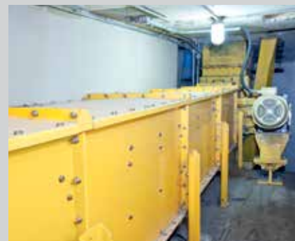
TCRA PARA DESCARGA DE MOEGA
