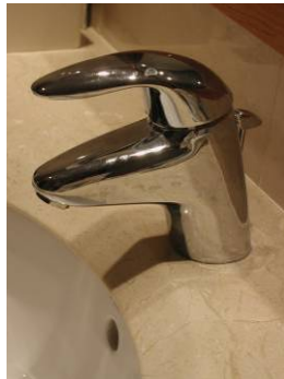
Figura 38 – Torneira com manípulo monocomando
