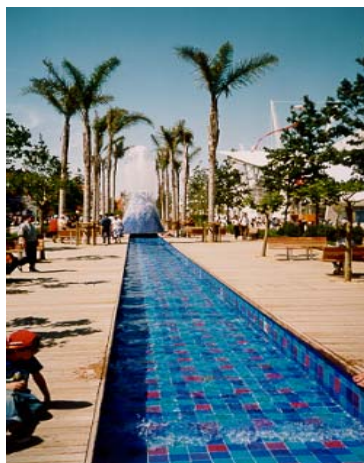
Figura 64 – Recirculação de água em jogos de água
