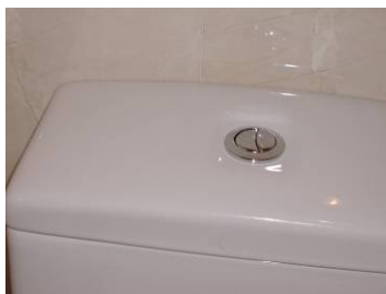
Figura 21 – Autoclismo de dupla descarga
