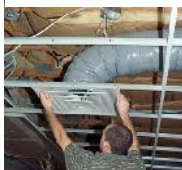
Instalação do HVAC - Difusor
