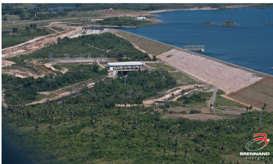
Foto 6: PCH Graça Brennand, no Rio Juba (MT). Fonte: Brennand Energia. Disponível em: < http://www.brennandenergia.com.br/site/imagens.php?c=13 >. Acesso em: 21/01/2014.
