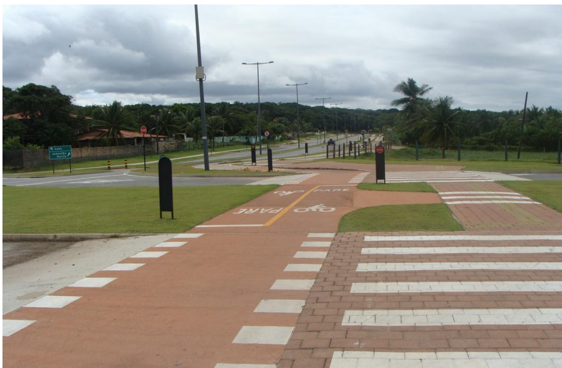
Foto 7: Aspecto do alto padrão de qualidade da Via Parque, com destaque para a sinalização da ciclovia e da calçada para o pedestre. Fonte: Adauto Gomes, jun / 2011.
